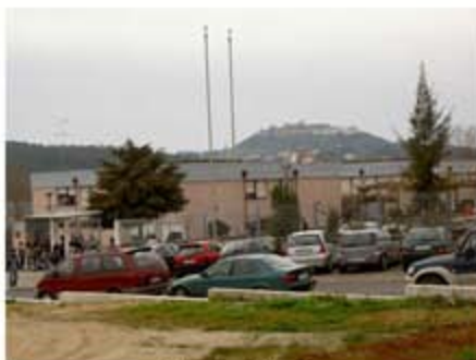
Exterior da Escola
